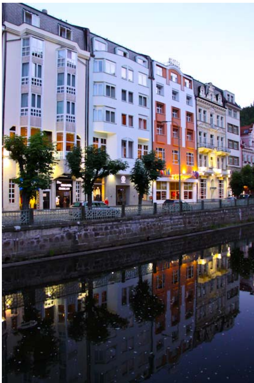
Im Sommer 2012 restaurierte das Dvořák Spa Hotel Karlovy Vary seine Fassade
